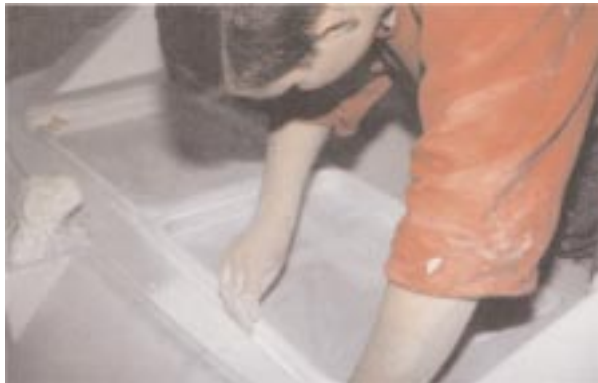
Der Aufbau wird zum Lackieren vorbereitet
