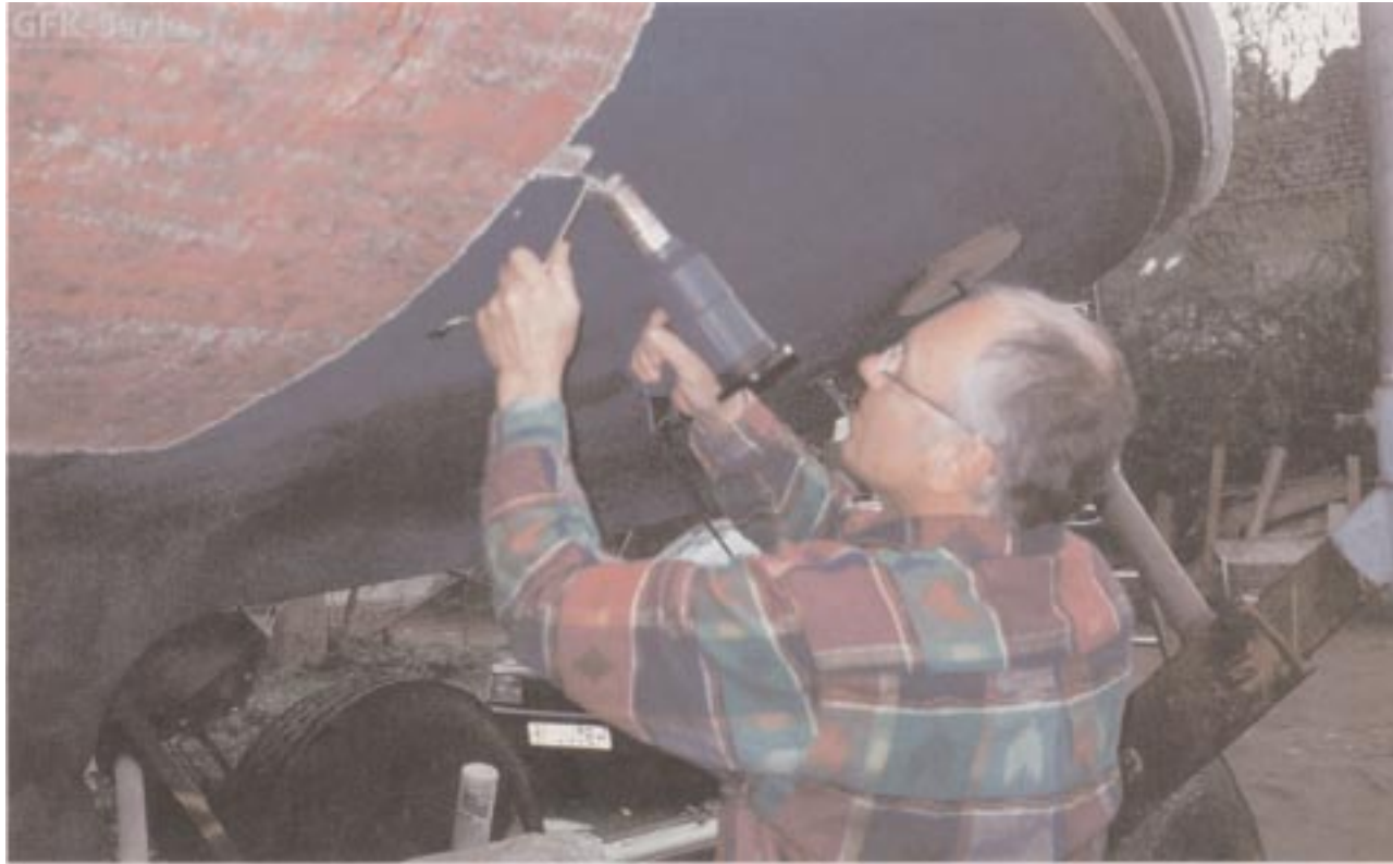
Dieser Eigner entfernt vor der Osmoseprophylaxe mit Epoxidharz das Antifouling mit einer Heißluftpistole
